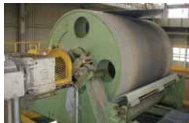
13. Mesure de traction de bande sur ligne de galvanisation
